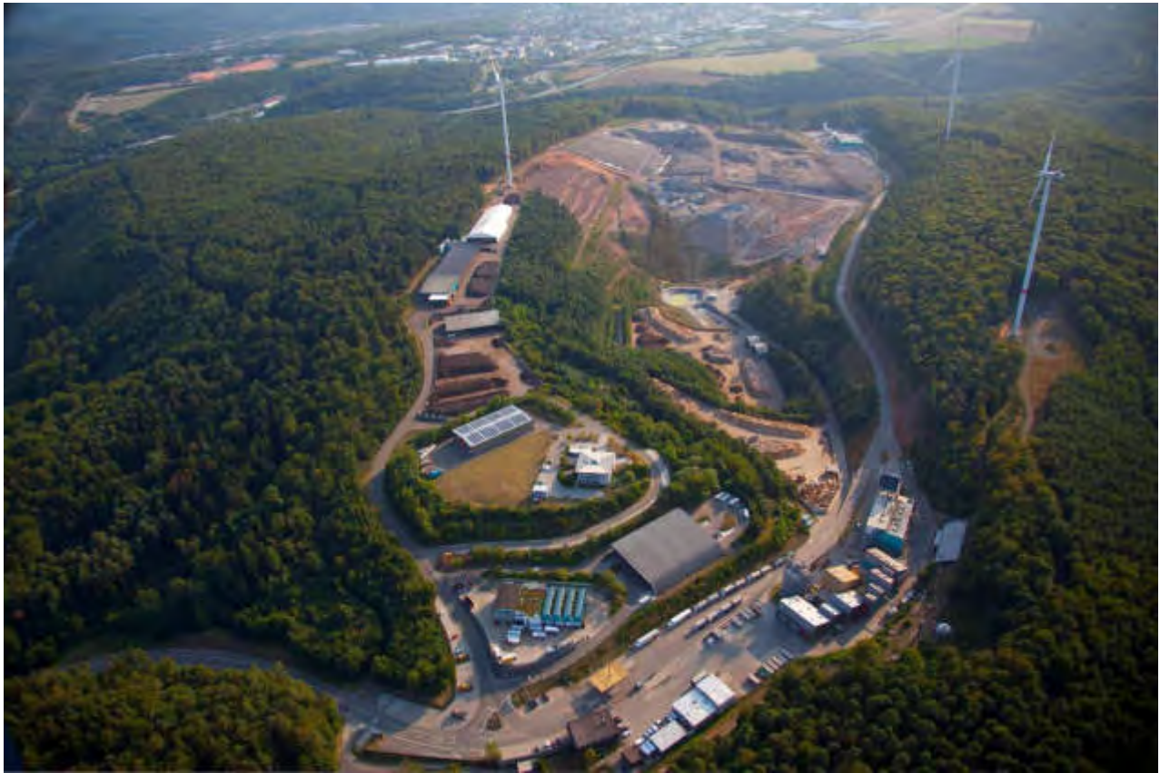
Abb.: Abfallwirtschaftszentrum Kaiserslautern – Mehlingen
